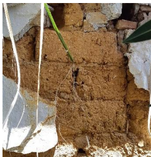
Εικόνα 6. Οι ωμόπλινθοι του κτίσματος στη περιοχή Νεροκούρου (αρχείο Δ. Καδά).
