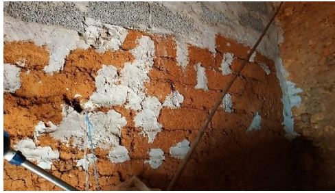
Εικόνα 7. Τοίχος αποθήκης από ωμοπλινθοδομή δίπλα σε πέτρινη οικία (αρχείο Δ. Καδά).
