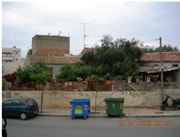
Εικόνα 3. Πλινθόκτιστο κοντά στο ιστορικό κέντρο των Χανίων (αρχείο Α. Μουσουράκη).
