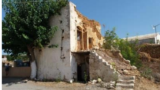
Εικόνα 10. Κτίσμα με ωμόπλινθους στον όροφο κοντά στο Ρέθυμνο (αρχείο Α. Μουσουράκη).
