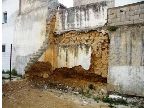
Εικόνα 13. Ίχνη πλινθόκτιστου κτίσματος στο Ηράκλειο (αρχείο Α. Μουσουράκη).
