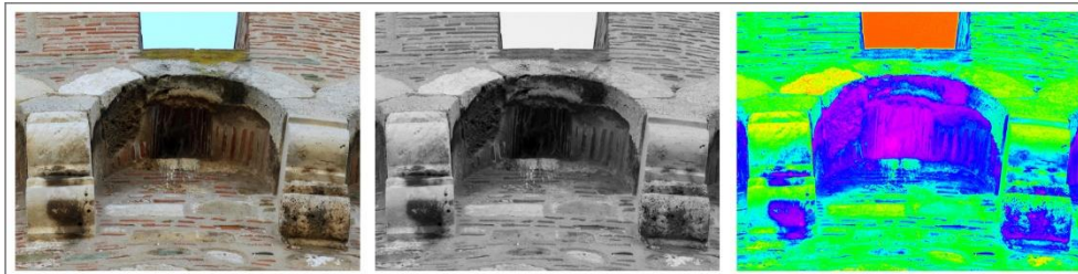
Εικόνα 8: Πρόβολος (φουρούσι) πυργίσκου: α. γυψοποίηση, β. μαύρη κρούστα, γ. κυψελώσεις.
