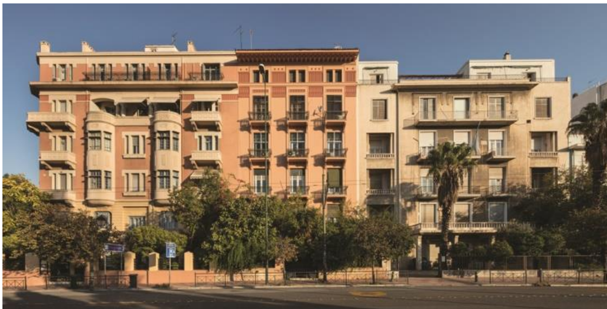
Εικόνα 9: Τρία κτήρια του ιστορικού κέντρου της Αθήνας κτισμένα στην δεκαετία του 1920, επί της Λεωφόρου Βασιλίσσης Σοφίας 55-59.
