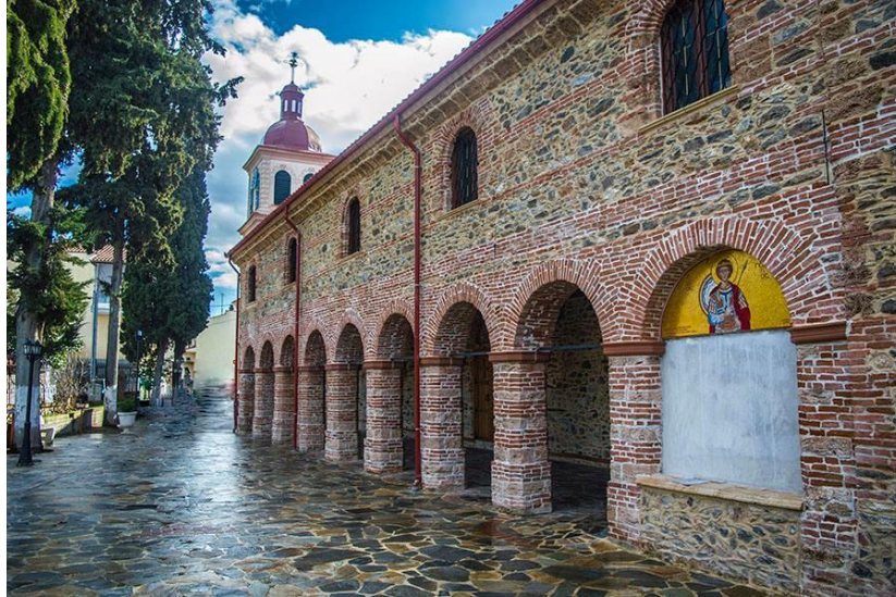
Εικόνα 1. Ο Ιερός Ναός Αγίου Γεωργίου Ασβεστοχωρίου
