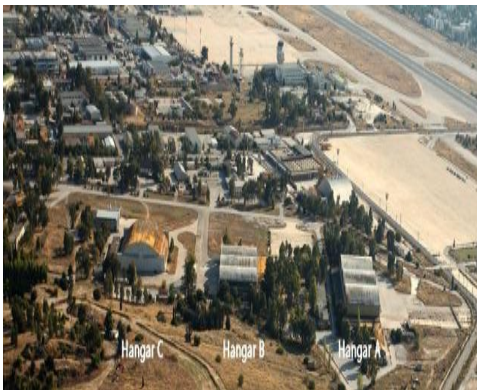
Εικόνα 2 : Τα 3 πρώην υπόστεγα της Πολεμικής Αεροπορίας | The 3 former Hangars of Air Force
